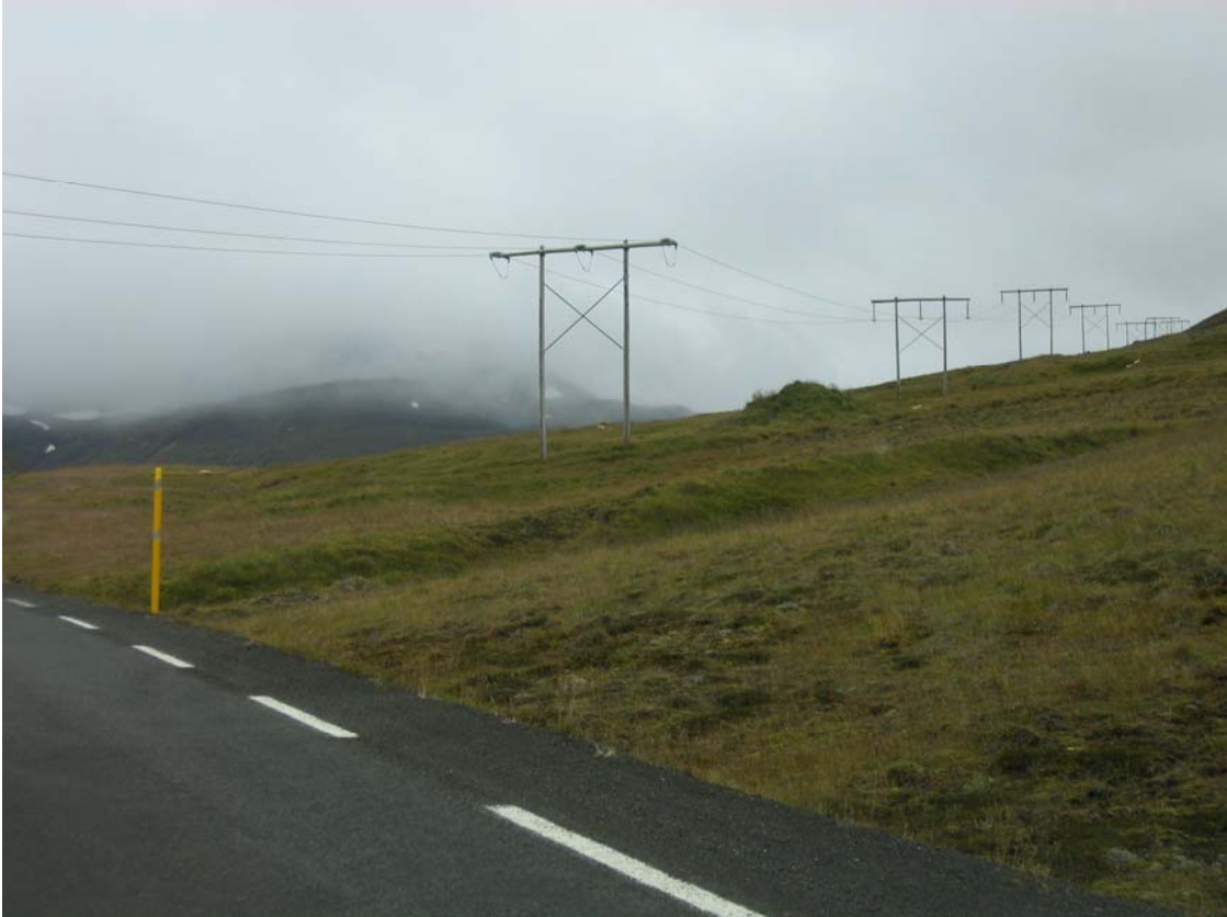
Mynd 48 Þverun núverandi byggðalínu rétt vestan við Bakkasel í Öxnadal. Horft af þjóðvegi 1 þar sem gamla byggðalínan þverar veginn við Bakkasel. Blöndulína 3 fer samsíða henni vestanverðri yfir veginn. Myndin sýnir útsýnið frá þjóðvegi 1 á vesturleið. Ljós. G.Ólafsdóttir.
