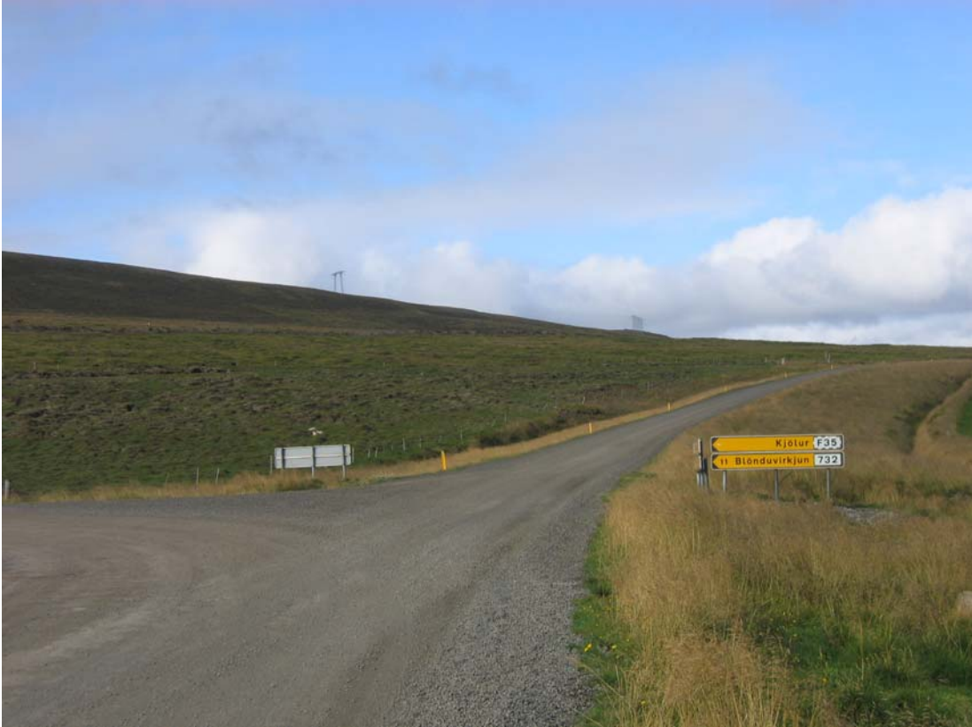
Mynd 10 Vegamót Kjalvegjar og 733. Myndin er tekin af veg 733 og horft í norðvestur. Háspennulínan sem sést í hliðinni efst fylgir vegfarendum 11 km leið frá vegamótunum að Blönduvirkjun. Ljós. G.Ólafsdóttir.
