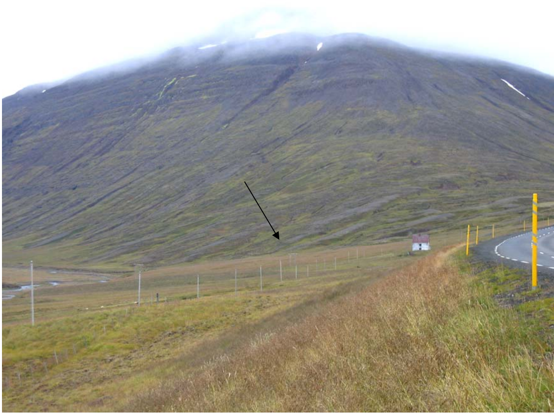
Mynd 49 Við Bakkasel í Öxnadal. Bakkasel við Kjaldbakshjúk. Vaskárdalur til hægri. Myndin er frekar óskýr en samt gott gæmi um hve timburstaurar gömlu byggðalinunnar eru samlitir umhverfinu og girðingastaurunum í forgrunni. Örin bendir núverandi byggðalínu. Á þessum stað er Blöndulínu 3 ætlað að þvera gömlu byggðalínuna og liggja nær þjóðveginum. Ljós. G. Ólafsdóttir.
