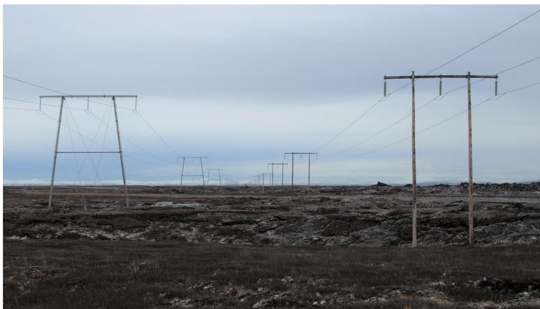
Mynd 4. Mismun á haflengd og umfangi nýrrar byggðalínu (t.v.), Kröflulínu 3 og eldri, Kröflulínu 2 má sjá hér á Mývatnsöræfum (ljósm. Hjalti Jóhannesson).
