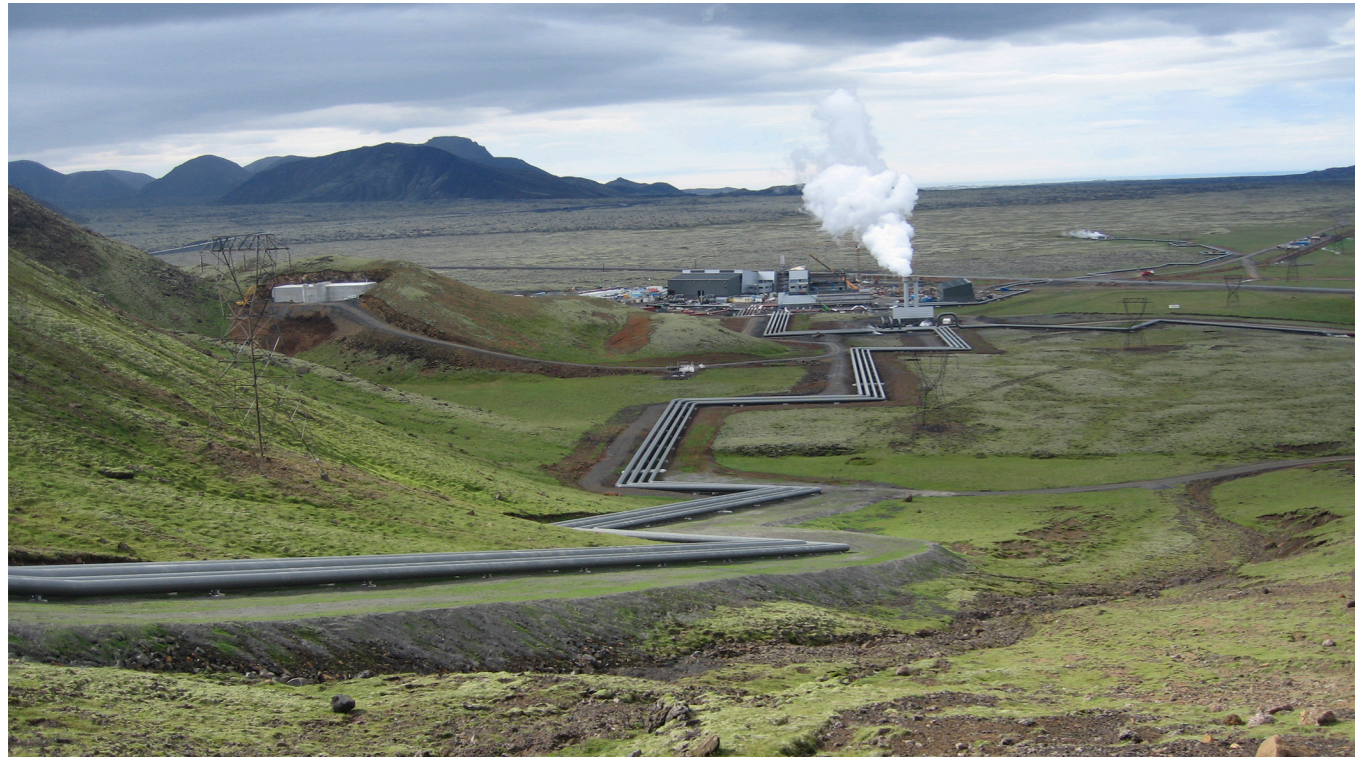
5. mynd. Hellisheiðarvirkjun séð úr Hellisskarði. – The Hellisheiði Power Station seen from the mountain pass Hellisskarð SW-Iceland. Ljósmynd: Anna Dóra Sæþórsdóttir.
