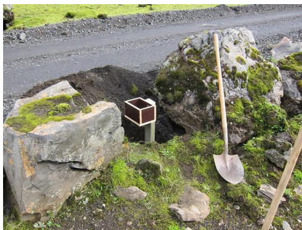
2. mynd. Bifreiðateljara komið fyrir í vegkanti.
